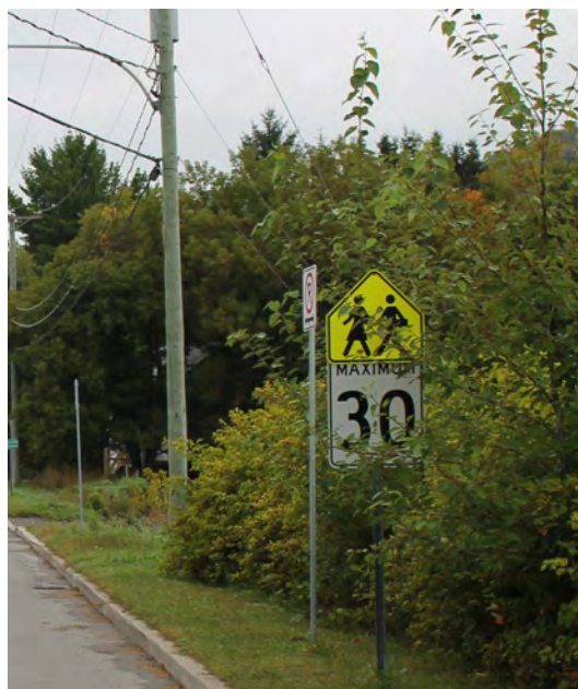
Figure 15 – Signalisation de zone scolaire dissimulée par de la végétation
