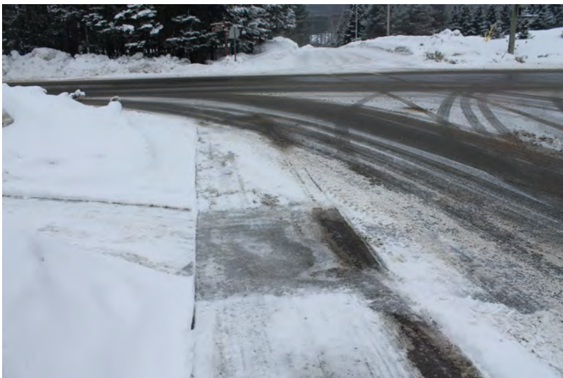
Figure 18 – Passage pour piétons du chemin du Hibou au mois de mars 2014.
